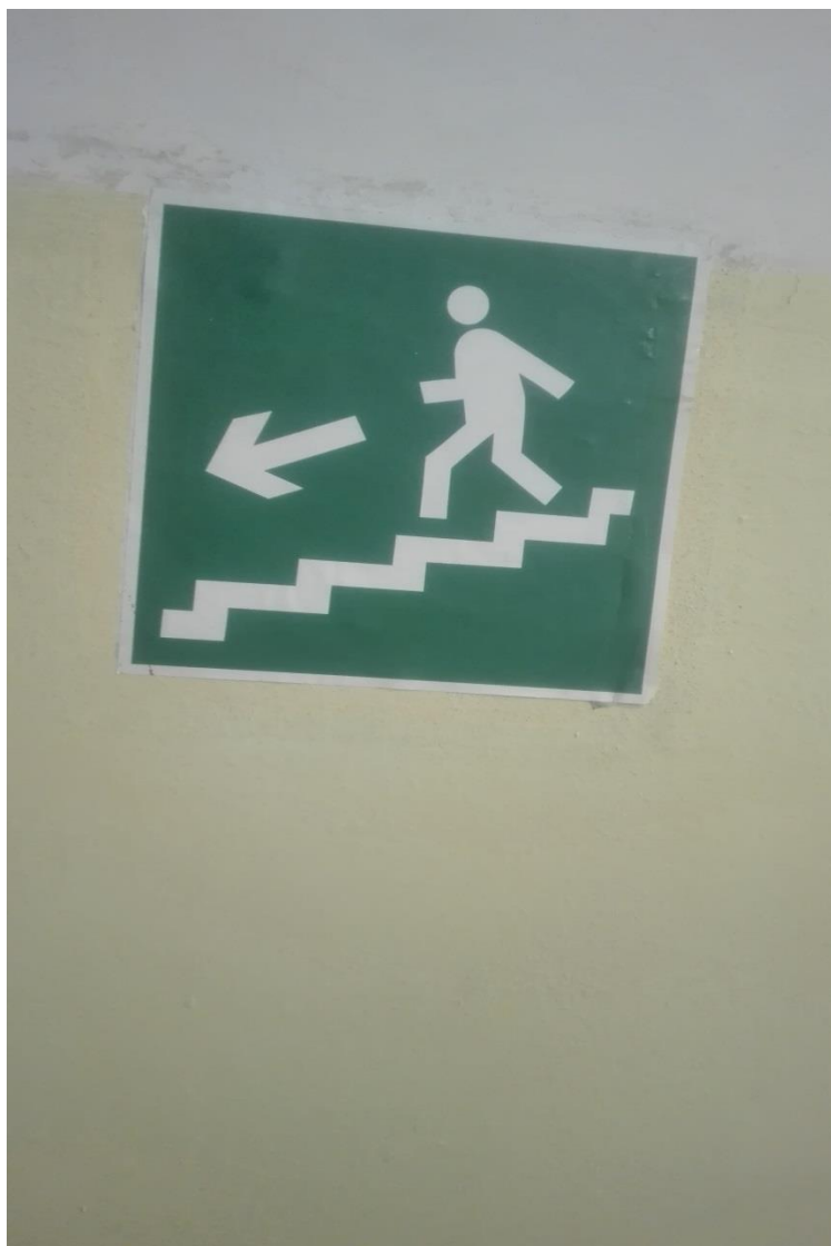
Фото №16 Визуальные средства путей эвакуации
