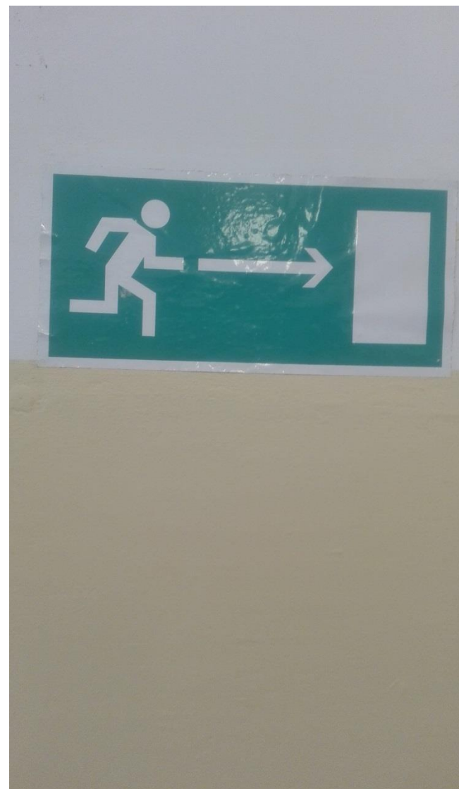
Фото №17 Визуальные средства путей эвакуации
